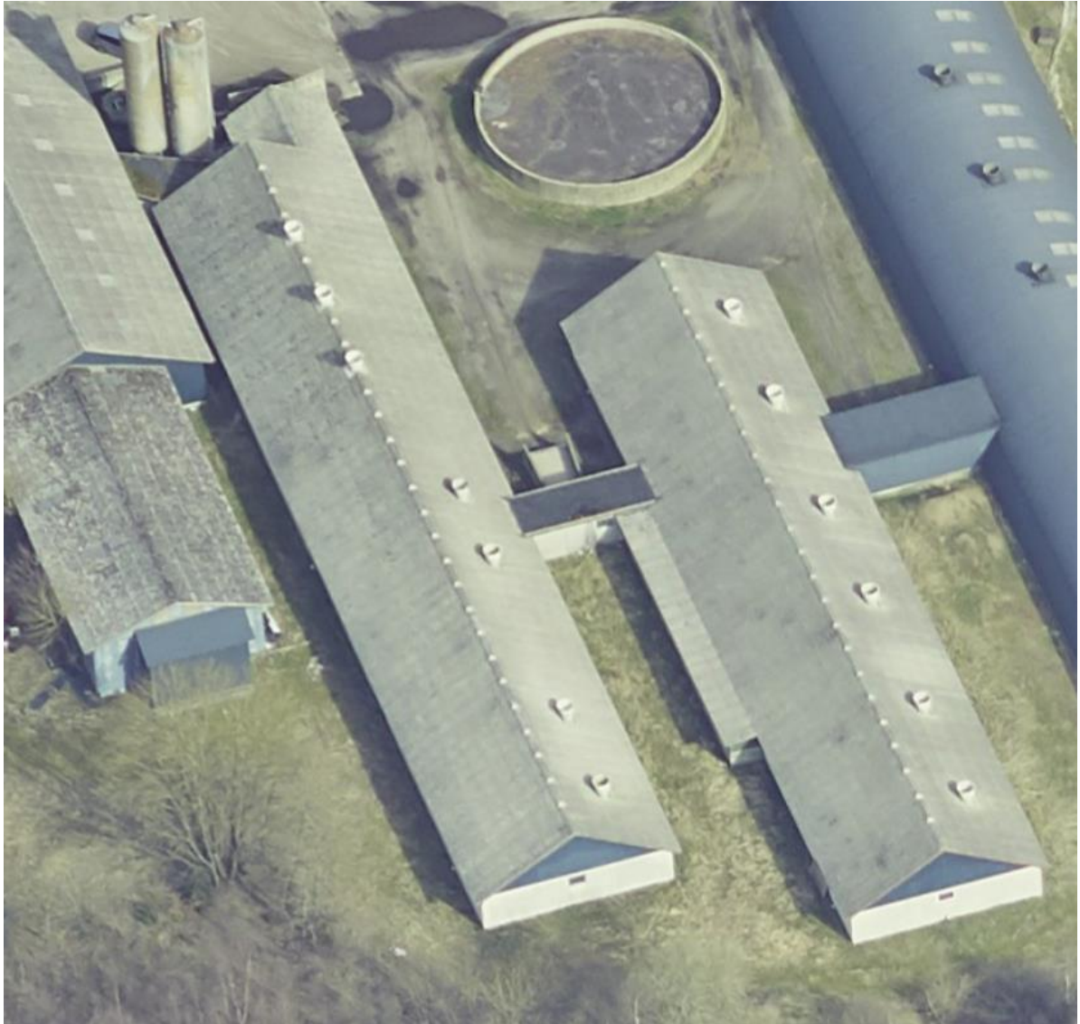
Figur 6 – eksisterende bygninger (1 til 5).
