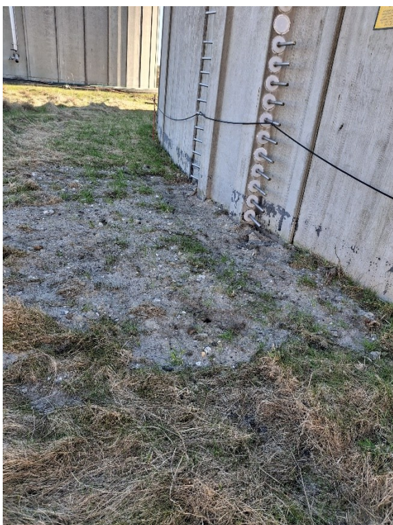
Foto 8 Hvor der har været gravet og tæthedskontrolleret
