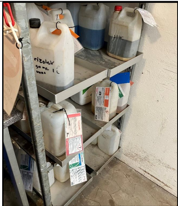
Kemirum til sprøjtemidler, hvor det kan være nødvendigt med højere kanter eller færre produkter
