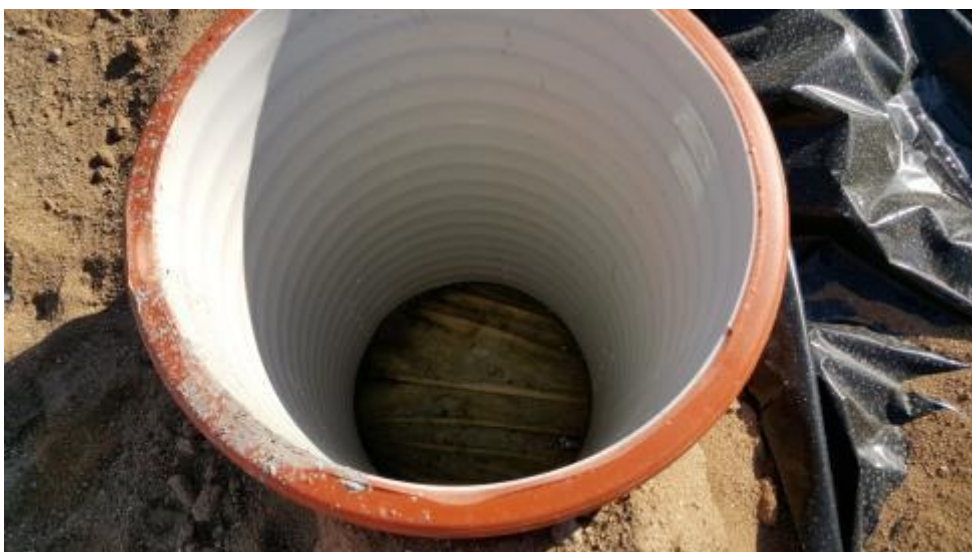
Figur 3: Brøndring placeret midlertidig inde på enhed 8 er ført ned til overside af geotekstil.
