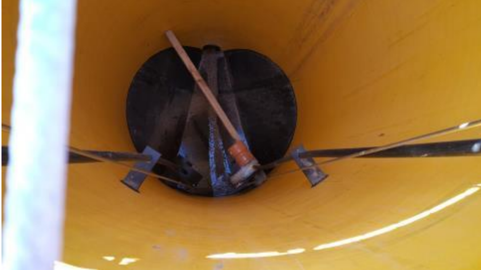
Figur 4: Afløb fra enhed 8 (til højre i billedet) er midlertidig afproppet indtil enheden tages i brug. Der er etableret prøveudtagningsmulighed på samme vis som for enhed 7 med prøvetagningsrør (til venstre i billedet).
