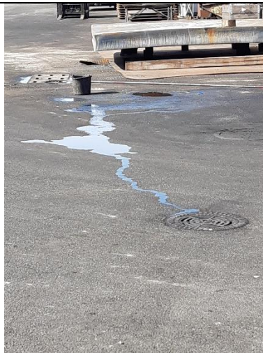
Afløb på vaskepladsen.
