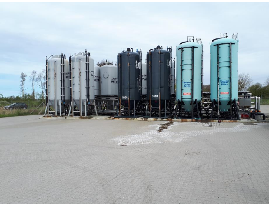
Kulfiltre til efterpolering af spildevand.
