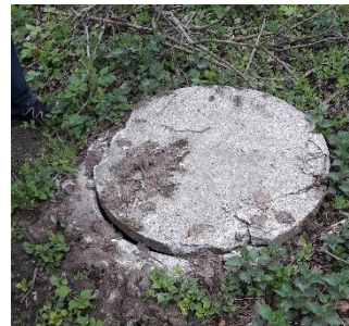
Figur.3 Ukendt brønddæksel vest for deponiet
