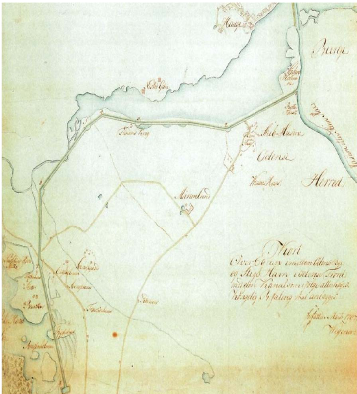
Figur 10 Det ældst bevarede kort fra udgravningen af Odense Havn dateret marts 1797, fra "Odense Havn og Kanal gennem 200 år" af Henrik Harnow, Odense 2005. Den gamle åmunding blev rettet ud, uddybet og udstyret med lange dæmninger ud i fjorden. Det nuværende udløb er således "menneskeskabt"
