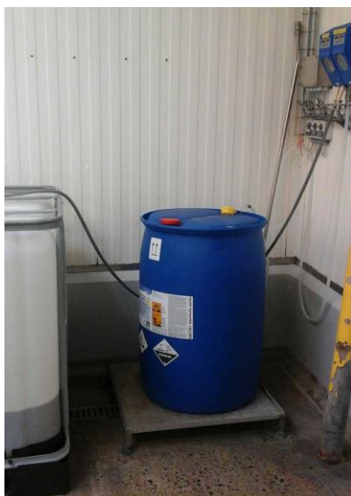
Billede taget i et af rummene, hvor virksomhedernes trucks står opbevaret, hvor der er risiko for afløb til kloak.
