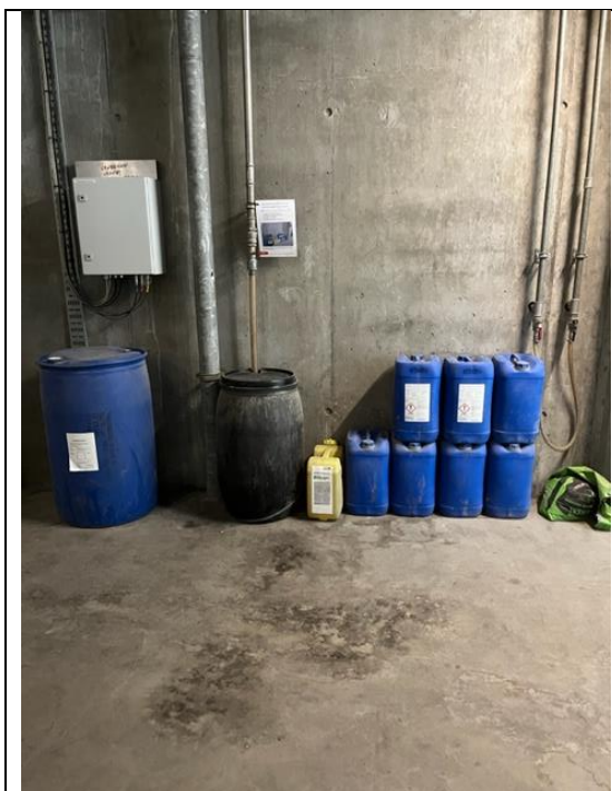
Foto 6: Skumstation 2: Sort tønde, forsyner via skumtilblander vand/skumkanon 2 med skumvæsken. Der er et oplag af skumprodukt.
