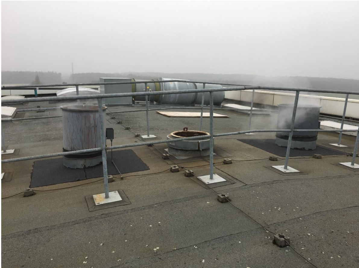
Figur 29: Afbłæsning fra opstartsventil over tag (midterste afblæsning)
