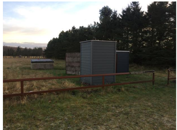
Skydehus (foto fra tilsynet i 2016)
