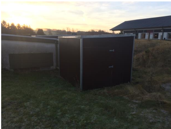
Skydehus (foto fra tilsynet i 2016)
