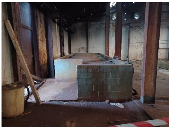
Sydvestlig del af den store produktionsbygning (t.v.) og i næste bygningsafsnit (t.h.) tidl. grav og zinkgryde (bagerst), hvor hullerne er fyldt op med grus og stampet
