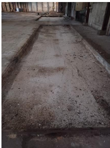
Sydvestlig del af den store produktionsbygning (t.v.) og i næste bygningsafsnit (t.h.) tidl. grav og zinkgryde (bagerst), hvor hullerne er fyldt op med grus og stampet
