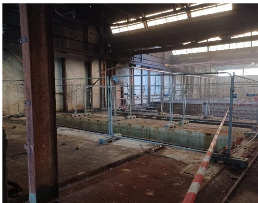
Sydvestlig del af den store produktionsbygning (t.v.) og i næste bygningsafsnit (t.h.) tidl. grav og zinkgryde (bagerst), hvor hullerne er fyldt op med grus og stampet
