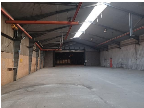
Sydvestlig del af den store produktionsbygning (t.v.) og i næste bygningsafsnit (t.h.) tidl. grav og zinkgryde (bagerst), hvor hullerne er fyldt op med grus og stampet
