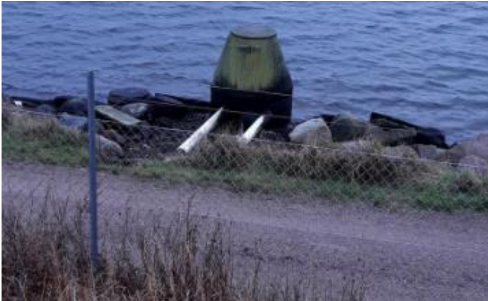
Figur 2. Prøvebrønd ved udledningspunkt.
