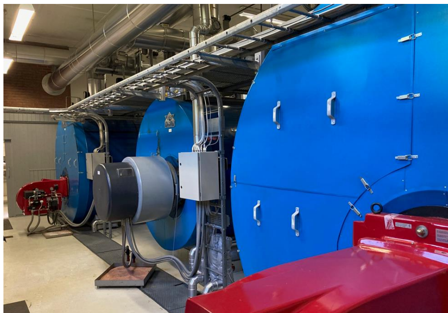
Kedelrum med OK1 (5,2 MW) tættest på.
