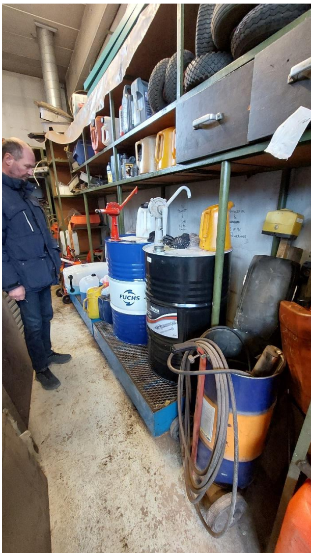
Opbevaring af hydraulikolie og motorolie på spildbakke
