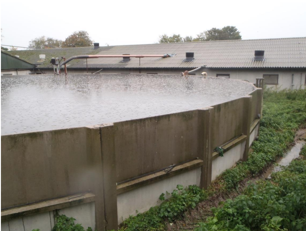
Billederne viser omrørt gyllebeholder på 1550m 3
