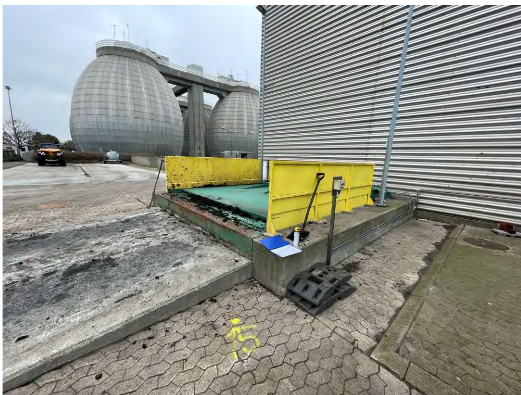
Foto 8: Indgang til slamsilo.
