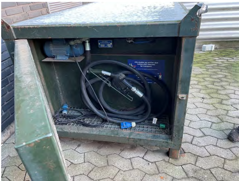
Foto 7: Udendørs overjordisk dieseltank, placeret nord for centrifugestation.
