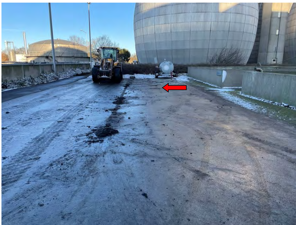
Foto 4: Vaskeplads til vask af køretøjer, som tilkører slam. Olieudskiller OU2, vist med rød pil, er tilsluttet til vaskeplads.
