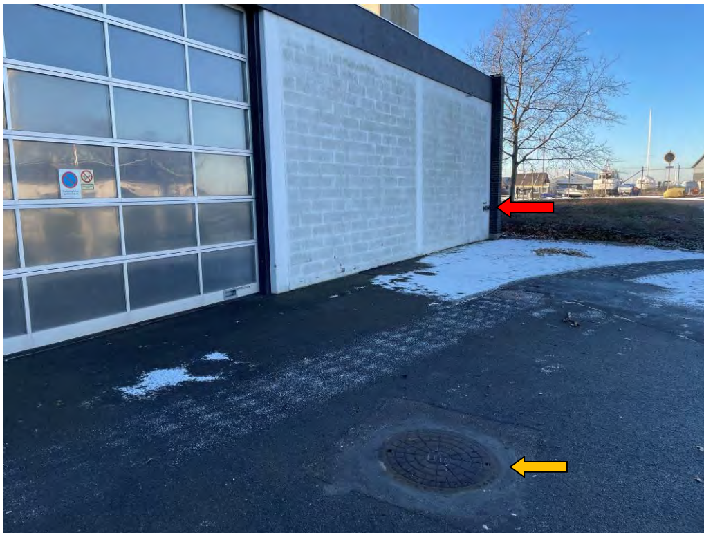
Foto 1: Olieudskiller (OU1) og påfyldningspladser vist hhv. med orange og rød pil, placeret nord for gasmotorrum.
