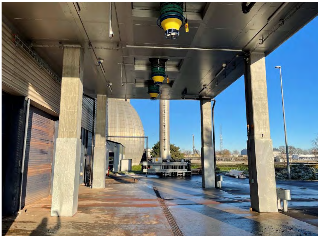
Foto 5: Nyligt opført område øst for forbrændingsbygværket, som skal anvendes til læsse lastbiler med aske eller røggasaffald, der skal sendes til nyttiggørelse.
