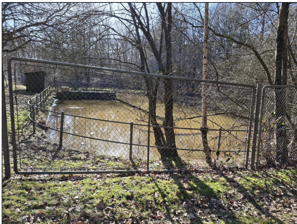
Foto 6: Ringkanalanlæg, hvori perkولات opsamles forud for afledning til Gram Renseanlæg.
