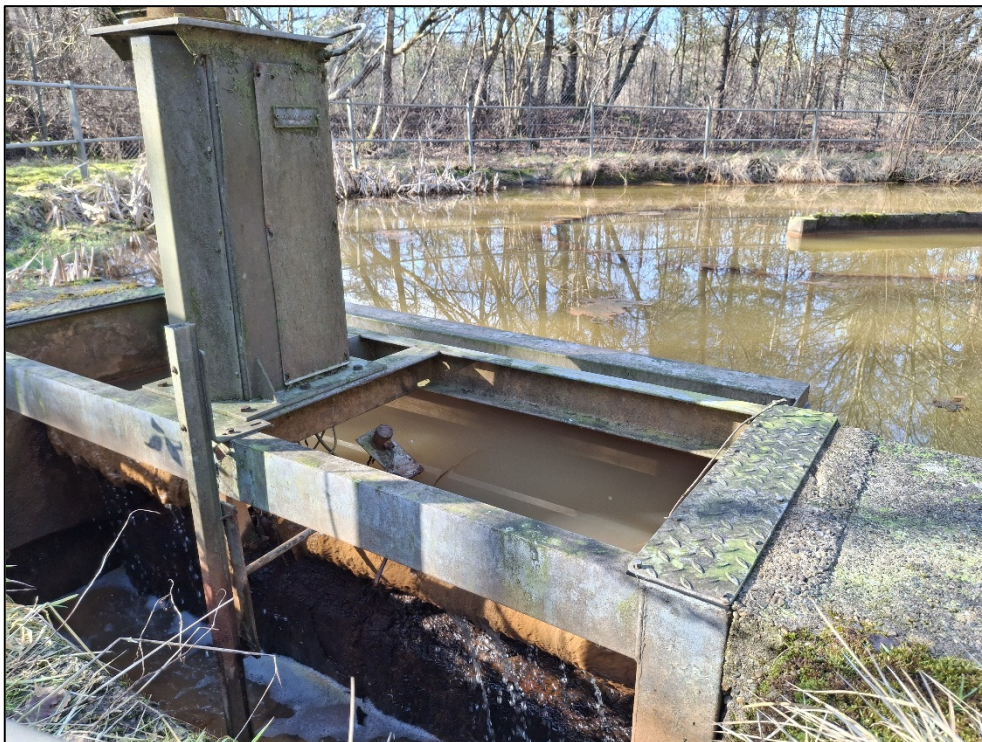
Foto 7: Overløbsbygværk fra ringkanalanlægget.
