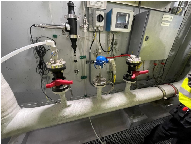
Figur 15 Prøvetagningsudtag samt målere til pH, temperatur, turbiditet.
