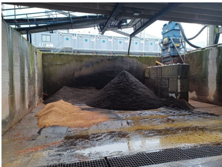
Figur 13 Slagge/ Bundaske opbevares udendørs på overdækket slaggeplads.
