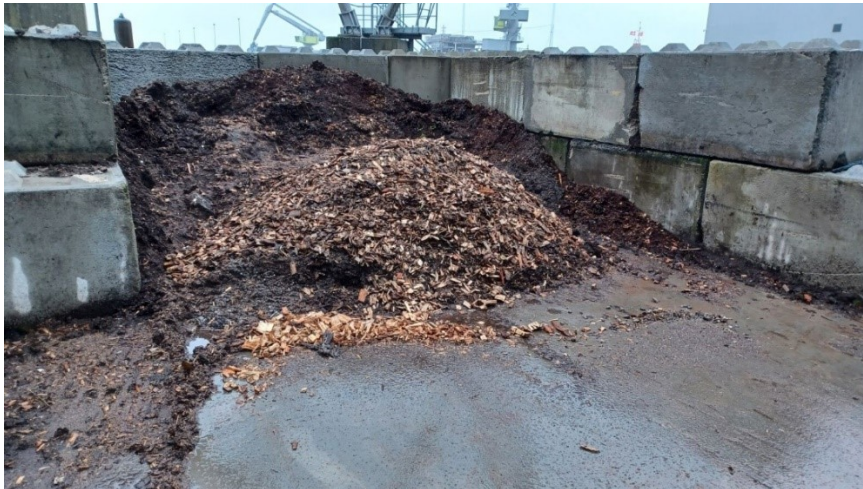
Figur 31 Flis fra vaskepladsen skrubes op og opbevares midlertidigt ved vaskepladsen. Det flyttes tilbage til den store flisbunke på stammepladsen.
