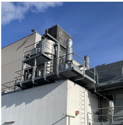
Figur 7 Afkast fra udsug på transportbånd på taget af blok 1.
