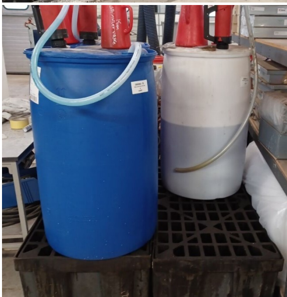
Figur 27 Olie og kemikalier opbevares i grav uden afløb eller på spildbakke.
