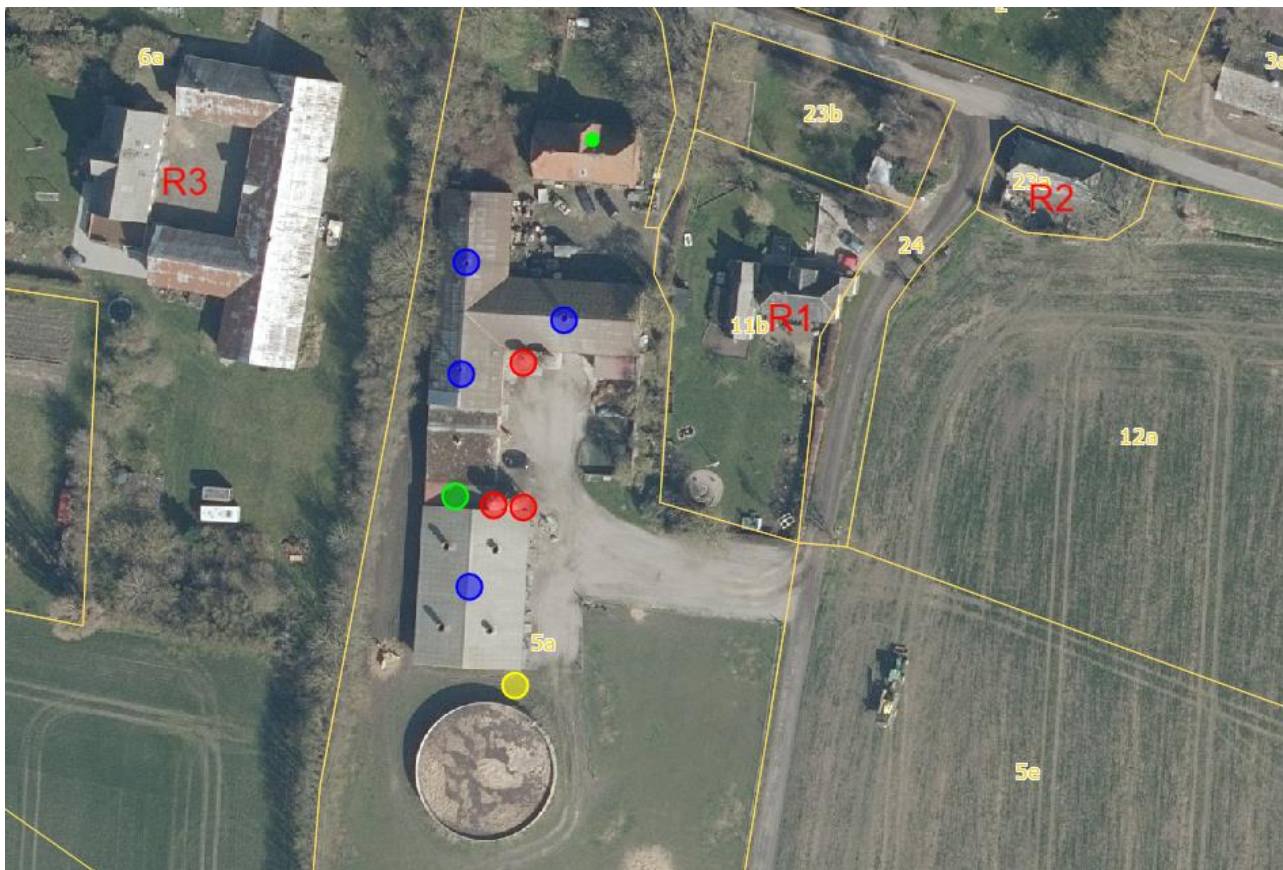
R1, Stjoul Fiskervej 6, R2: Stjoul Fiskervej 10, R3: Stjoul Fiskervej 2. Beregningspunktet placeres 15 m fra bolig i retning mod støjkilderne.
