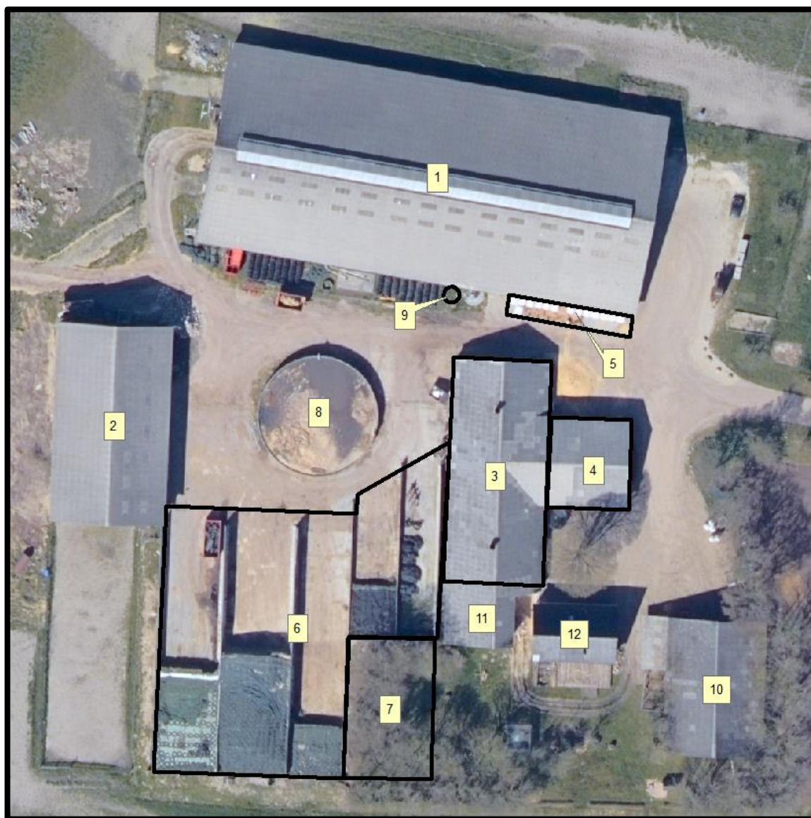
Figur 4. Oversigt over husdyrbrugets bygninger.
