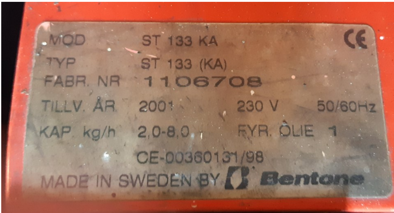
Figur 2: Mærkeplade på oliekedel
