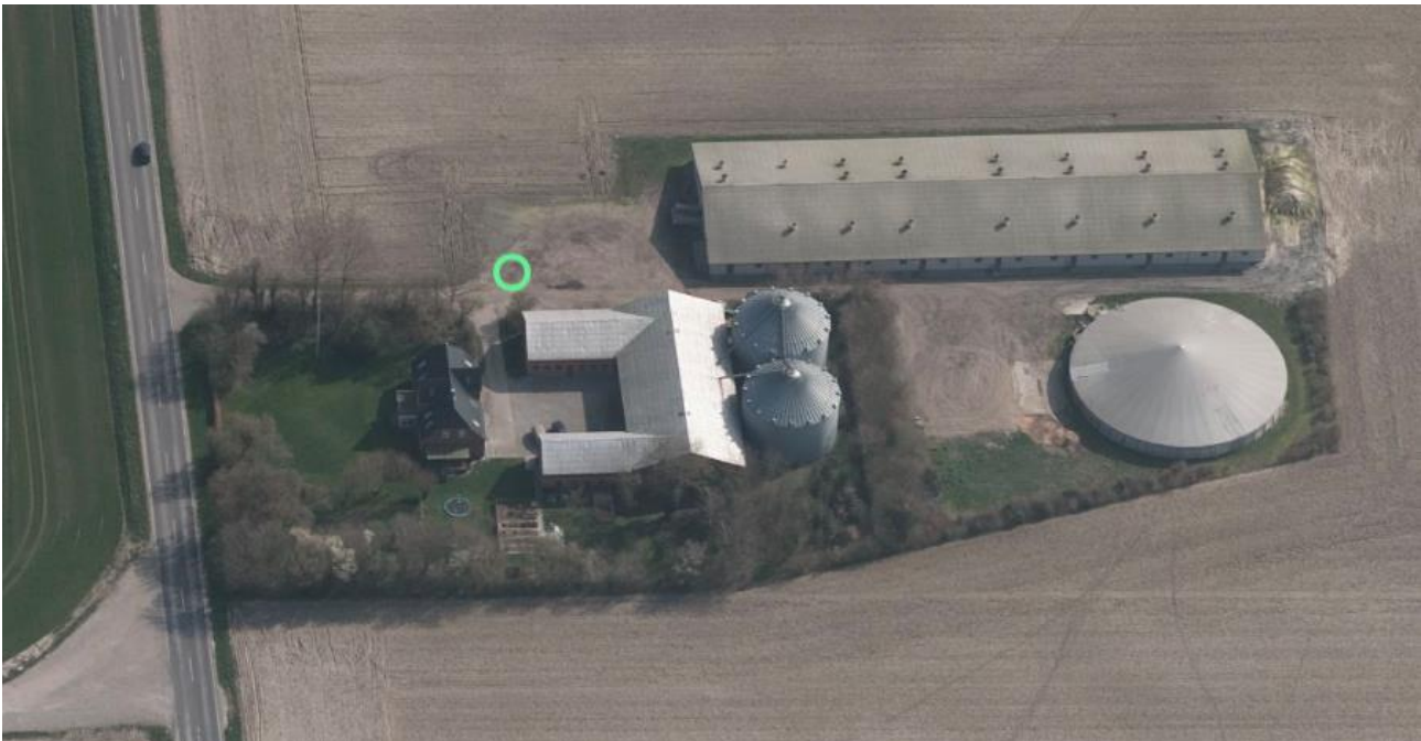
Luftfoto 3.2.1 Skodsebøllevej 29 set fra vest
