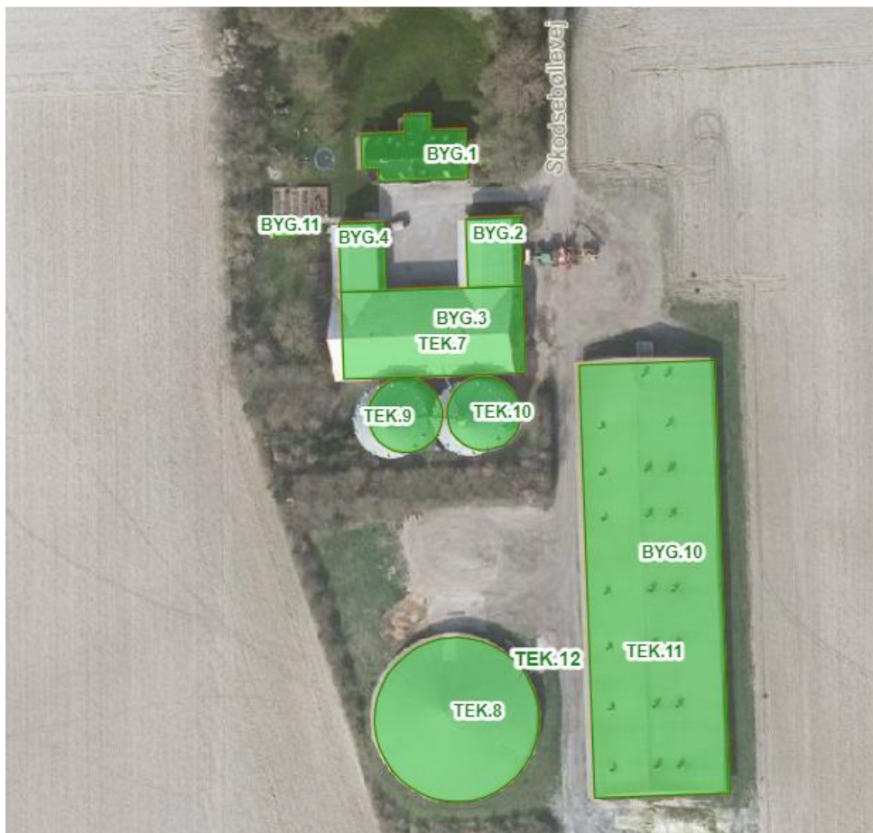
Luftfoto 2.4.1 oversigt over ejendommens bygninger og TEK anlæg
