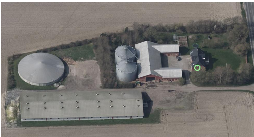
Luftfoto 5.2.1 viser placering af læsseplads nordøst for gyllebeholderen samt fortanken syd / sydøst
