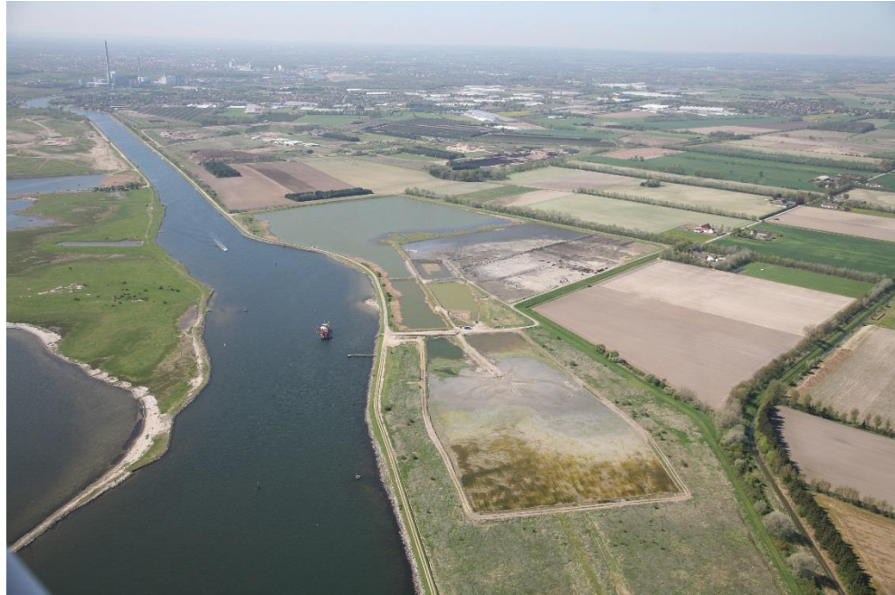
Figur 12-2 Luftfoto af spulefeltet, taget fra nord. På digekronen forløber gang- og cykelstien mellem Odense og Klintebjerg.
