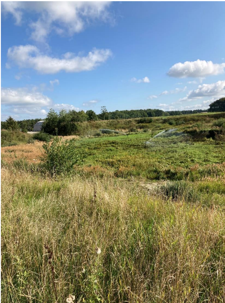
Deponi ses med sprinkling af perkolat.
