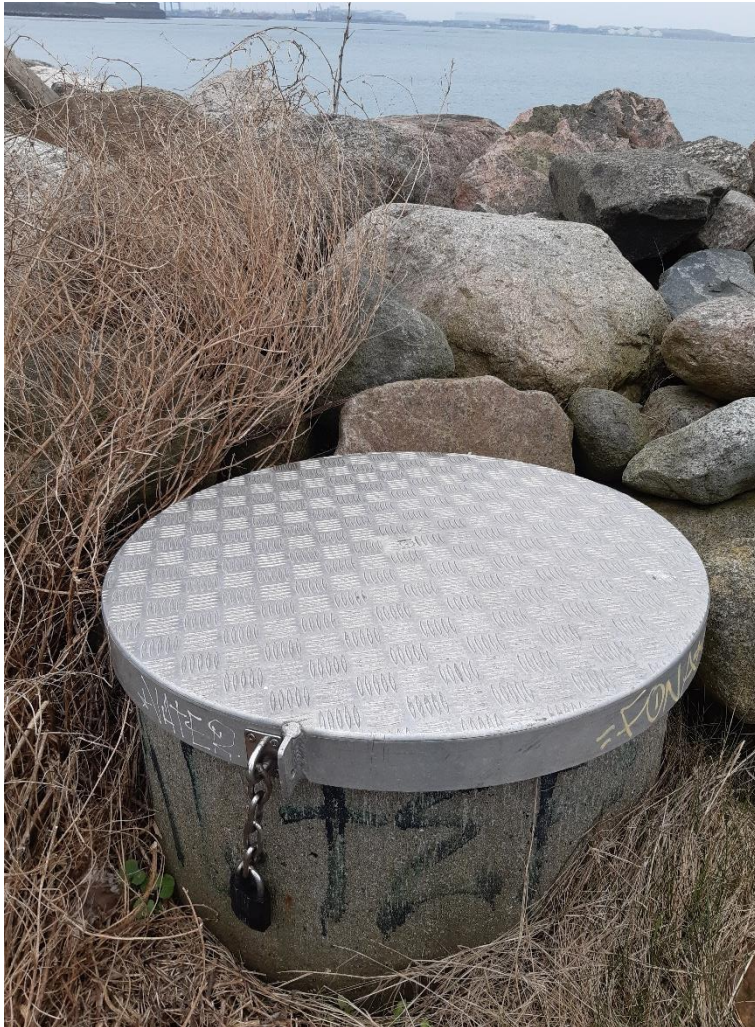
Foto 2: Prøvested B1 for perkolat beliggende på dæmningen.
