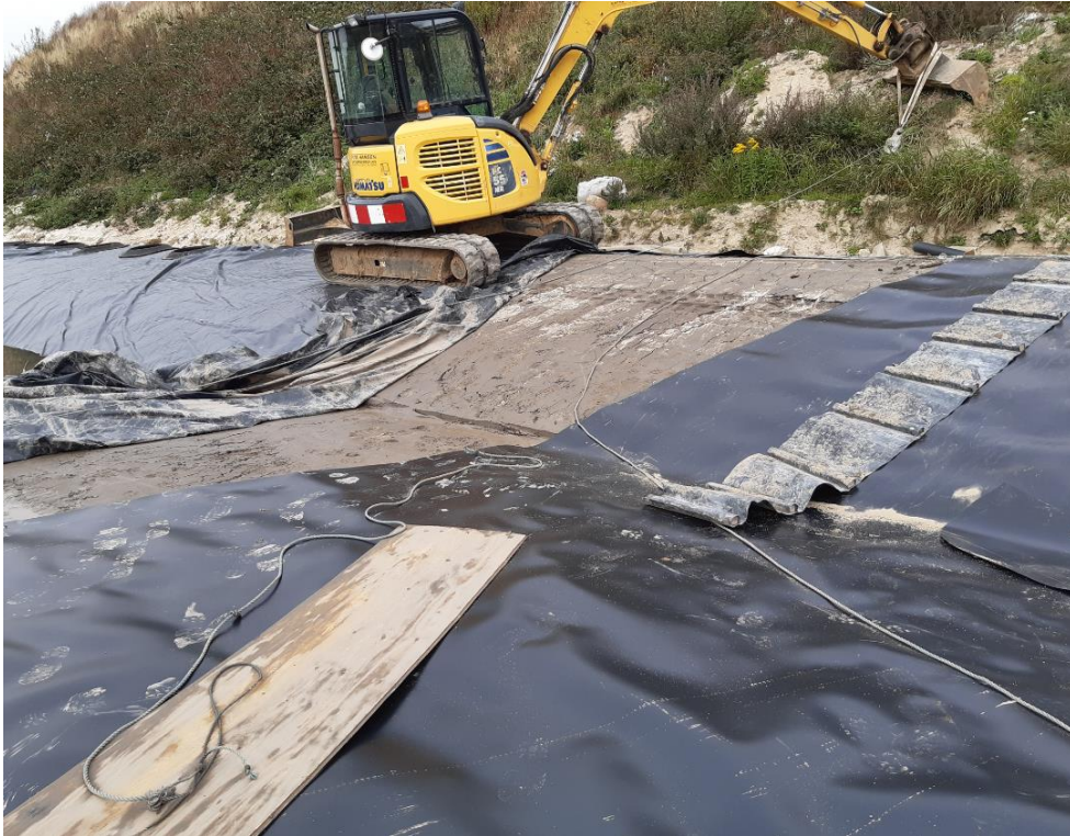
Foto 12 taget i retning mod gl. enhed 3A. Landbrugsplast til venstre og plastmembran til højre
