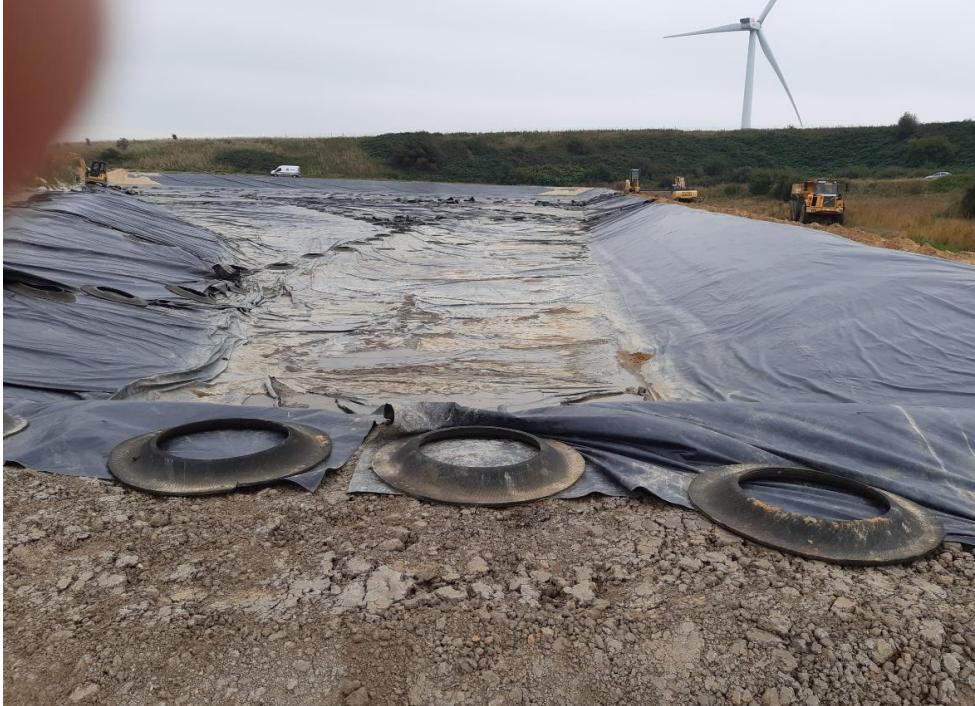
Foto 10 taget i retning mod øst fra den ende hvor udløbsdræn er. Landbrugsplast på lermembranen
