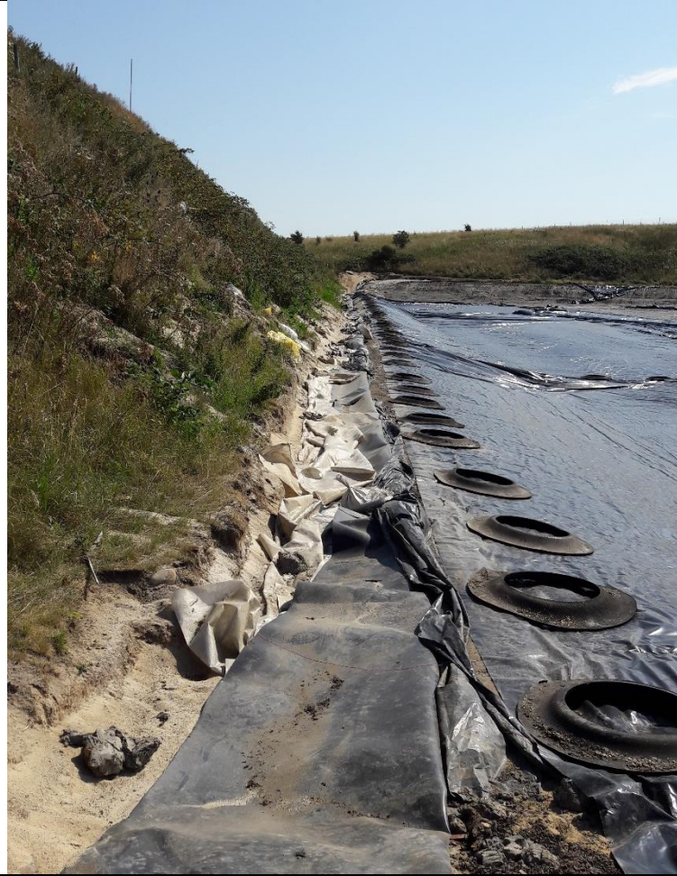
Foto 9: Foto langs etapens nordlige randvold i retning mod etapens nordvestlige hjørne. Fotoet viser blotlagt plastmembran fra tilstødende etape 3A.
