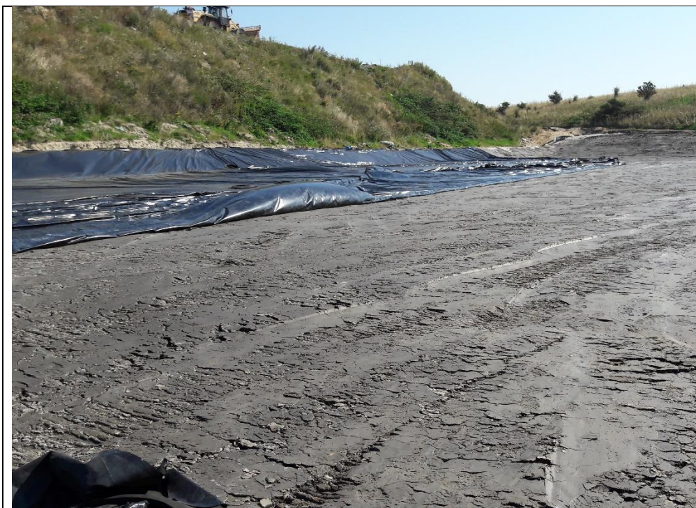
Foto 7: Generelt udtryk af det øverste lerlag dækkende etapens bund. Overfladen er godkendt af COWI. Fotoet er taget fra midten af etapen i retning mod etapens nordøstlige hjørne.
