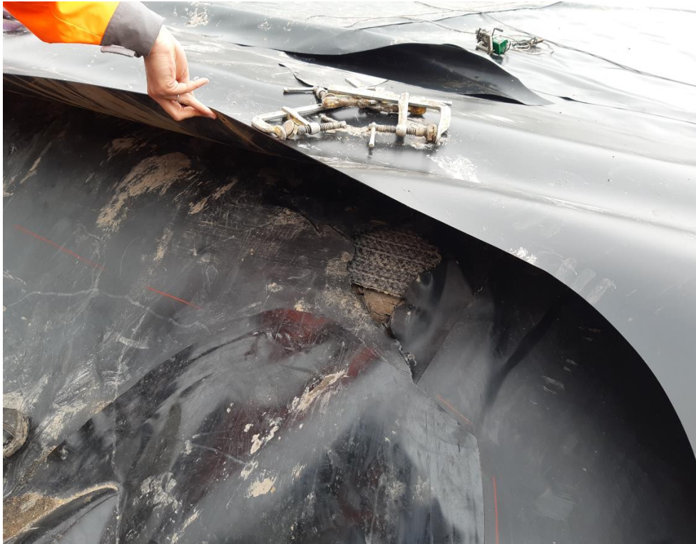
Foto 14 Hul i gammel membran der bliver lappet. bentonitmembran ses (ekstra beskyttelse ved overlap)
