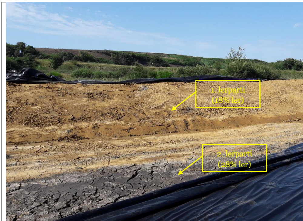
Foto 1: Foto taget mod sydvestlige randvold. Øverste lerlag på randvolden er fra første lerparti (lerindhold 18%). Øverste lerlag i bunden af etappen er fra andet lerparti (lerindhold 28%).
