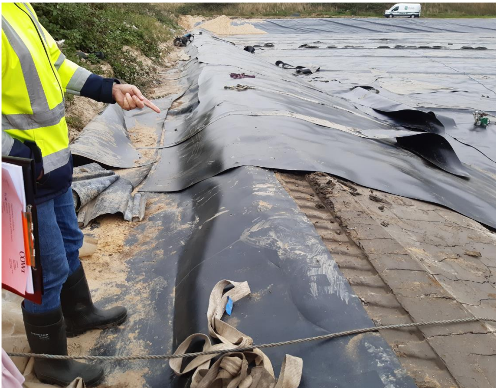
Foto 13 overlap mellem gl enhed 3A (til venstre) og ny enhed 4A til højre. Den gamle membran ses forrest i billedet
