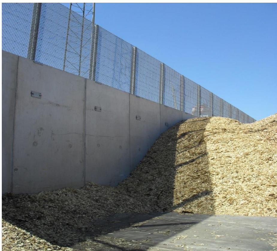
Foto 1. Nyetableret flisnet ved flislager
