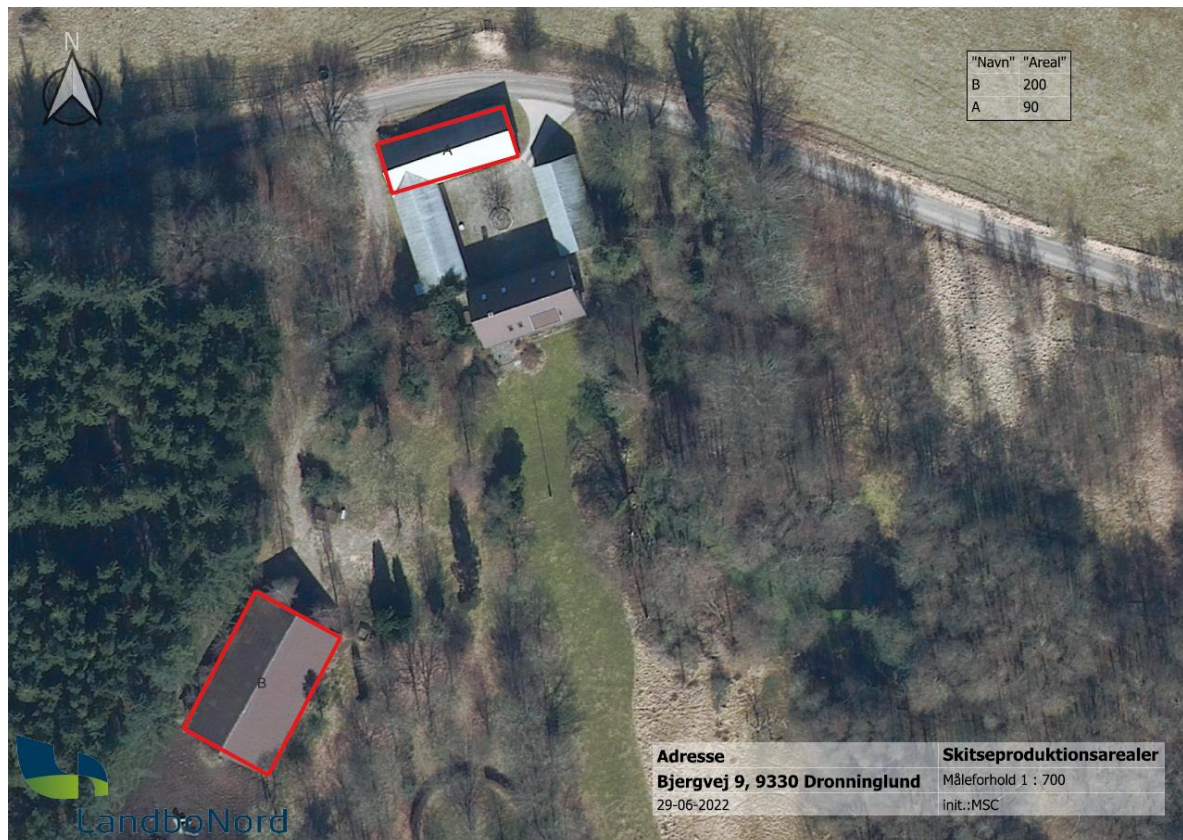
Bygninger hvor produktionsarealerne er placeret
