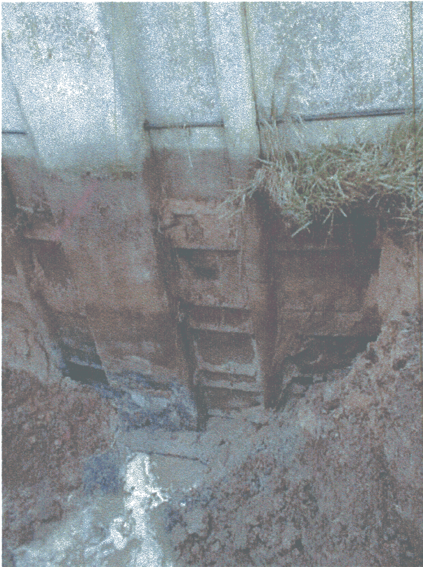
FOTO 2. OVERGANG M. BUND OG VÆG (VAAD I UDGRAVNING).
