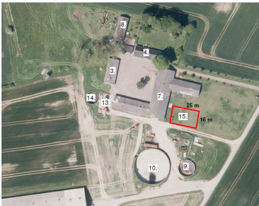
Figur 1 Maskinhus på 16 x 25 meter (bygning 15)
