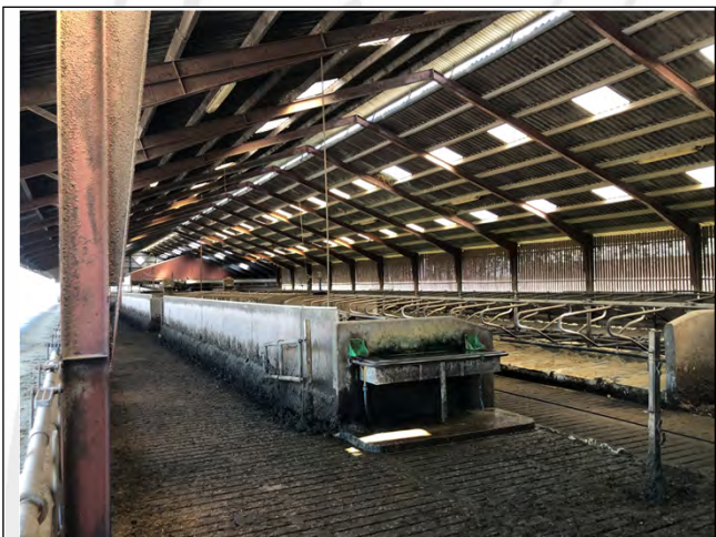
Kostalden set fra syd med sengebåse og udvendig foderbord
