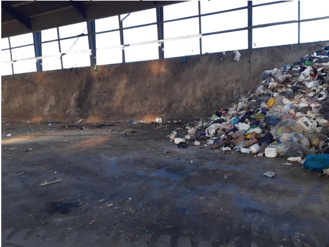
Billede 3 Sort afmærkning til venstre på væggen afmærkede oplagets maksimale størrelse. Nuværende oplag af dagrenovation ses til højre i billedet.
