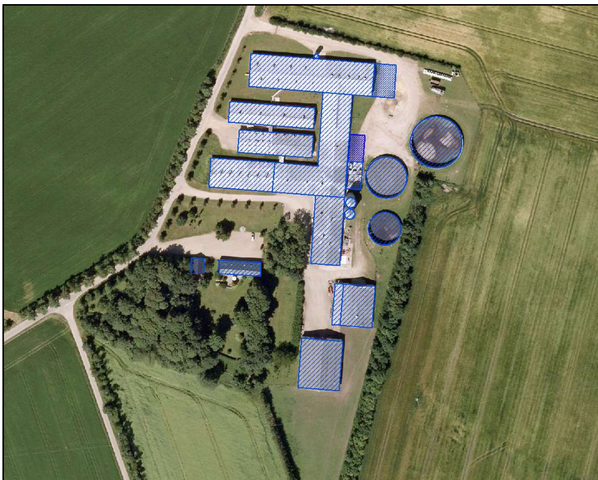
Figur 3. Eksisterende beplantning omkring anlægget.
