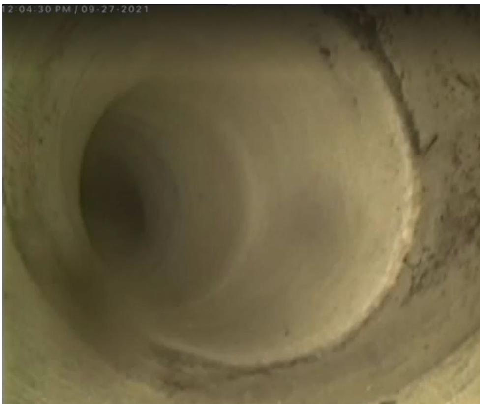
Figur 33 Strømpe udført i rør fra transformere til opsamlingskank.
