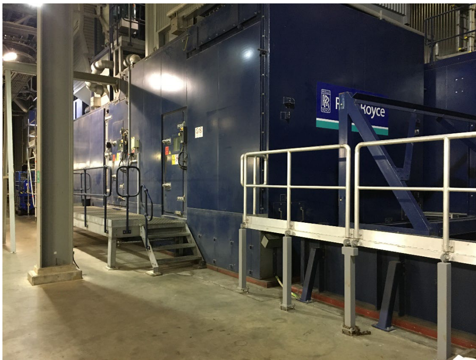
Figur 12. Gasturbinens indkapsling
