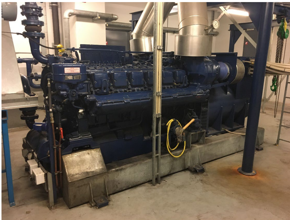
Figur 10. Nødstrømsanlæg blok 1
