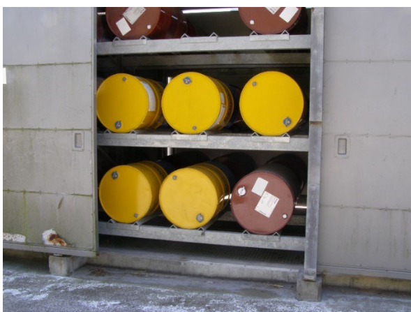
Figur 5. Oplag af smøreolie på reoler over beton opsamlingskar.
