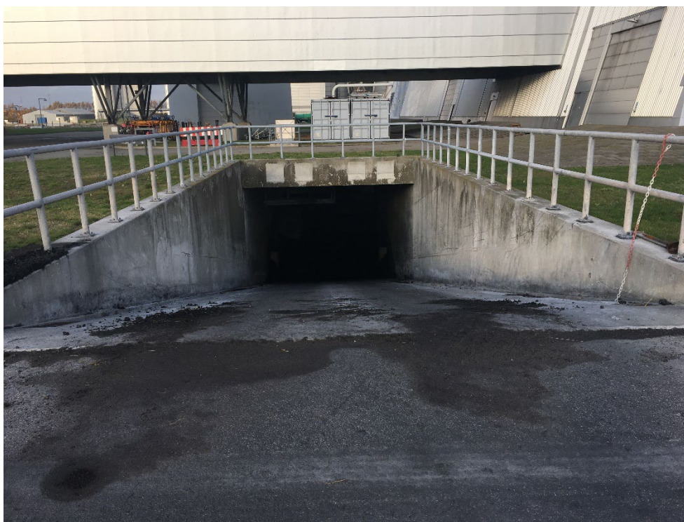
Figur 22. helstøbt betongrube for bundaske fra halmkedel. bemærk dybden af gruben der er under vandspejlet i tilstødende Køge bugt . Omliggende græsarealer er i kote 3,2.
