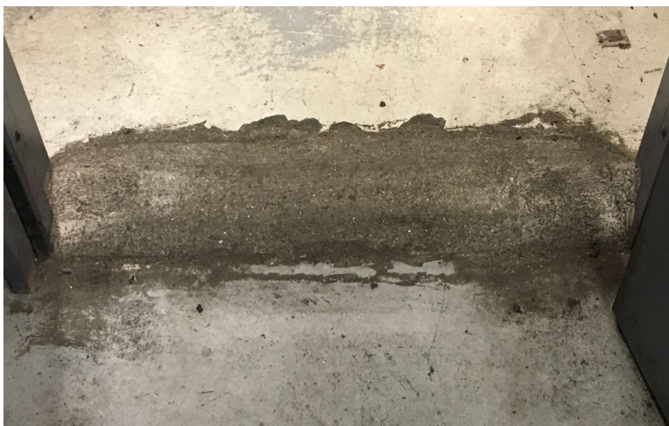
Figur 9. Forhøjning ved dørtrin til smørerum.
