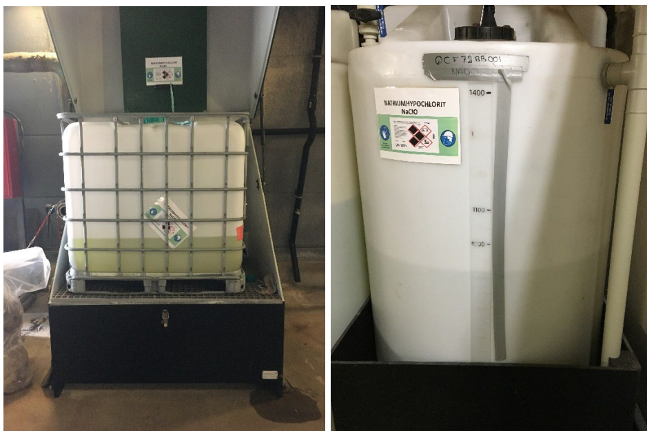
Figur 19. Lukket spildbakke for natriumhypochlorid palletank vist med låget åbent og forbrugsbeholder i spildbakke.
