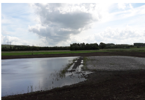
Fig. 5 Forsinkelsesbassin med sandfang
