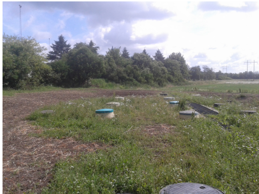
Fig. 1 Domerne med rislefilter
