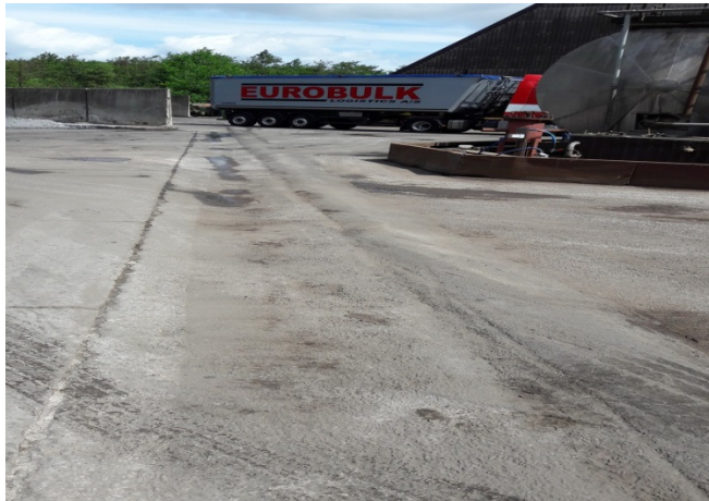
Fig. 7 Der er etableret opkant langs blegejordspladsen
