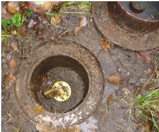
Figur 3: Den korte grundvandsboring K8, DGU nr. 193. 3050.
