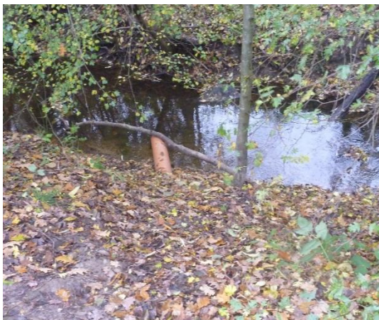
Figur 4: Udløb for drænvand fra under deponiet til Donse Å.
