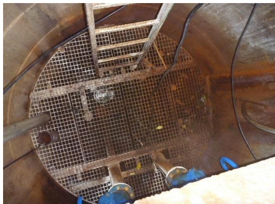
Figur 6: Perkolatbrønden hvorfra perkolat fra den nye del af deponiet og fra brønden ved amfiteateret ledes til målerbrønd og videre til kloak.
