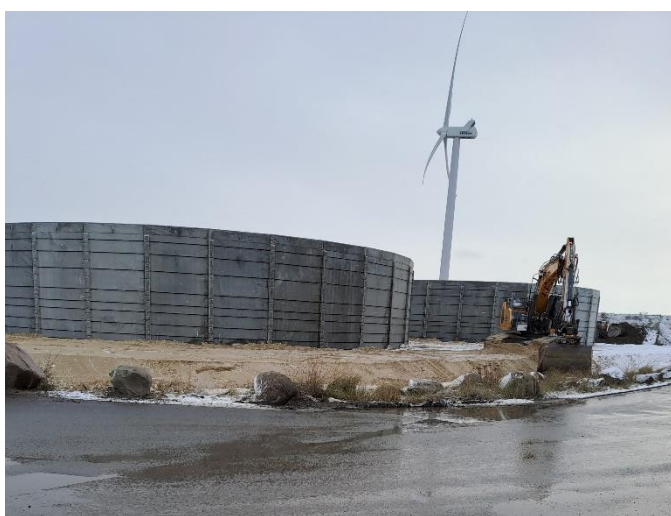
Billede 1: To nye forsinkelsestanke, som Norrecco har etableret i forbindelse med etablering af plads på Z-vej 1.
