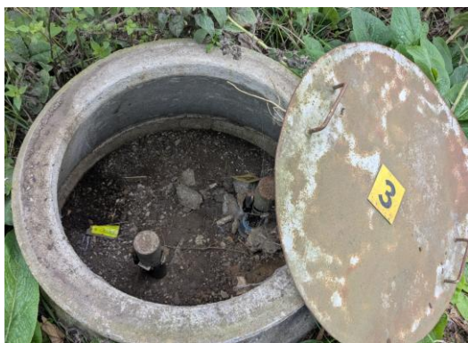
Foto 3. Grundvandsmoniteringsboring nr. 3, DGU nr. 89.1325 og 89.1320.
