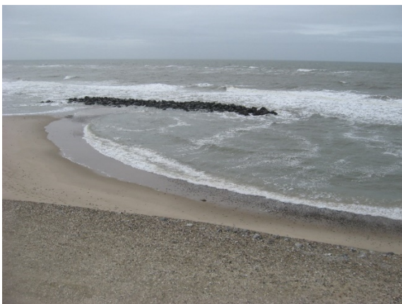
Foto. Sydligste bølgebryder hvor udløb etableres på vestsiden jf. Kystdirektoratets tilladelse.
