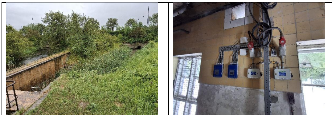
Figur 2. Pumpestation Selinevej-udløb til Nordre Landkanal
