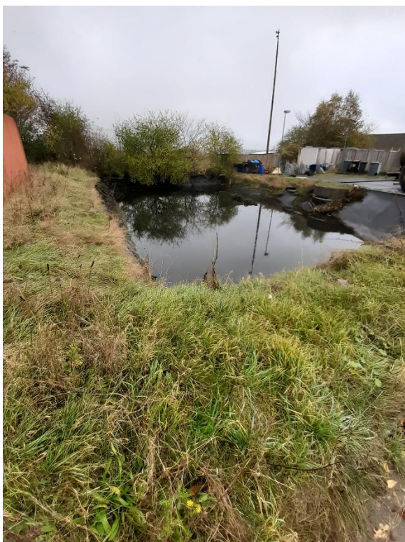
Foto af bassin til overfladevand, der anvendes til sprinkling på anlægget.
