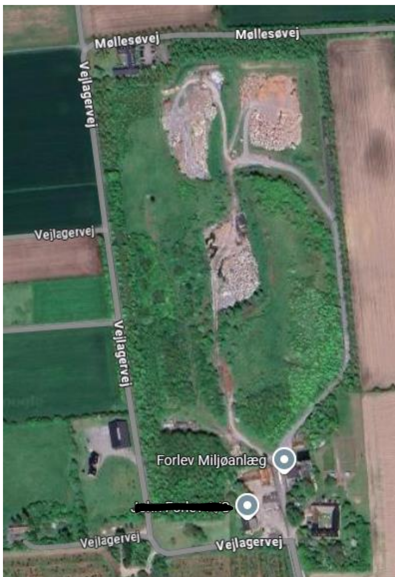
Forlev Miljøanlæg beliggende på Vejlagervej 4A, Vemmelev
