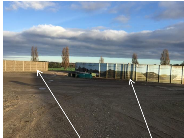
Billede nr. 8 (2018): Tank til vinasse-kali og afgasset biomasse
