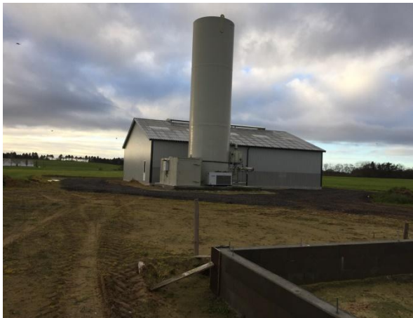
Billede nr. 1 (2018): Ny bygning til gaslager samt nyt afsvovlingsanlæg
