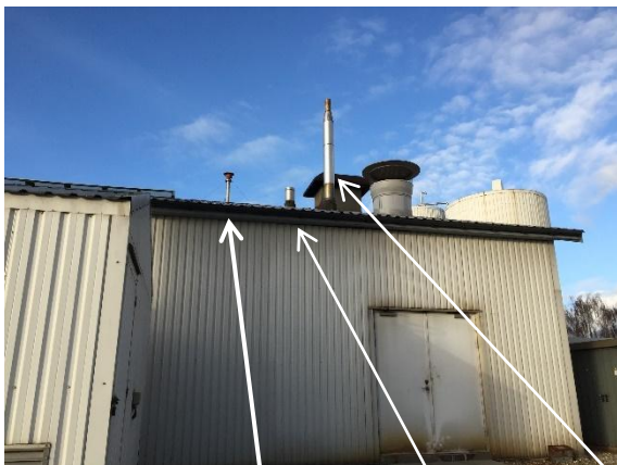
Billede nr. 9 (2018): Sikkerhedsventil, afkast gaskedel, afkast gasmotor.
