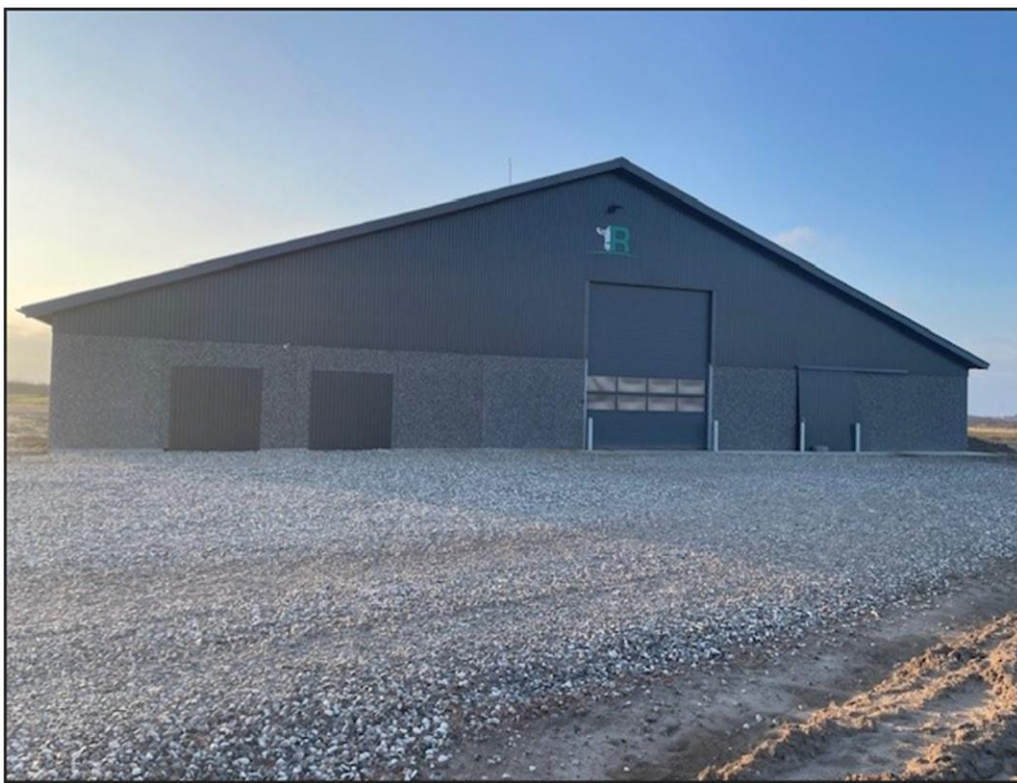
Facade ud mod Jernvedvej (stald 1)
