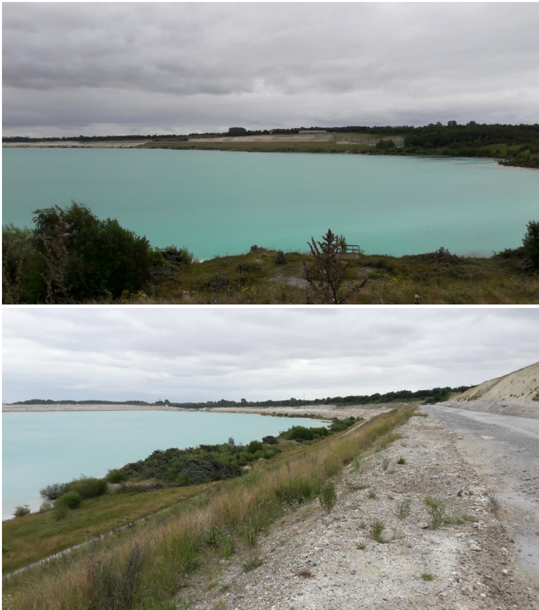
Figur 6. Øverst: Sigte mod NGA2 modsat søen med grøn græsbevoksning. Over etappen ses en stejl skrænt, som er gravefronten, hvor der ikke er udlagt materiale. Til venstre i billedet ses NGA3I, hvor opfyldningen er i gang. Nederst: NGA2 med asfaltvejen i højre side af billedet.
