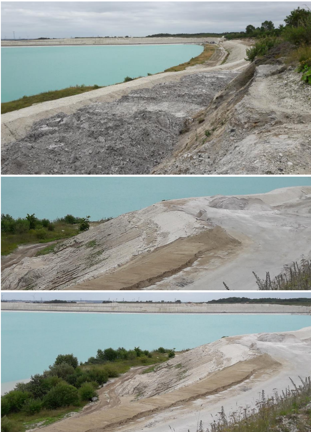
Figur 7. Øverst: Opfyldningen med microfiller på NGA3I. Yderst ses jordvolden og inderst ses opfyldt. Midterst: Afdækningen på NGA3I sker løbende. Fyldet dækkes af en lermembran, som dækkes med råjord. Nederst: Jordskred.
