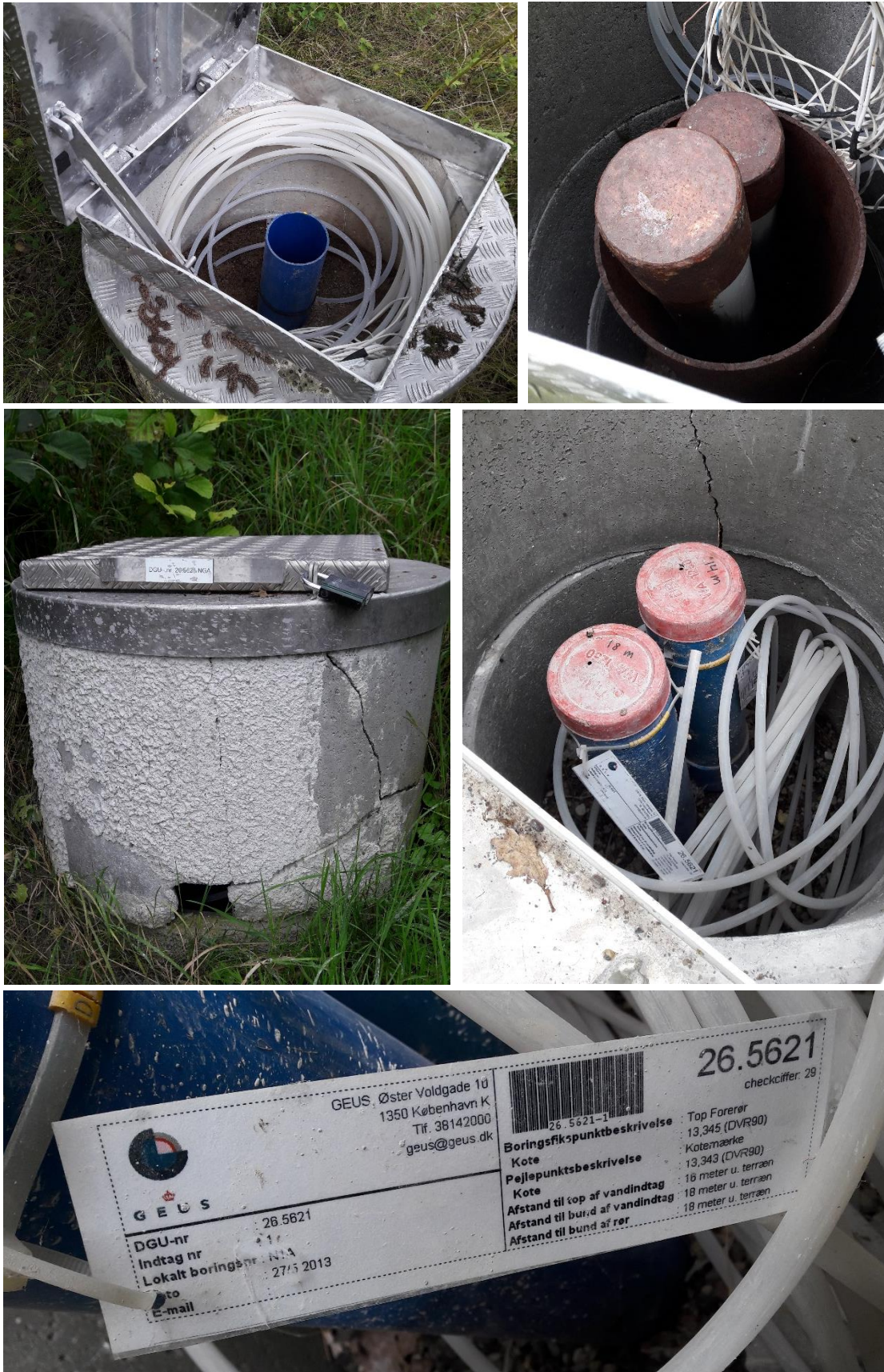
Figur 8. Øverst tv: DGU26.4897, brøndring og forerør. Øverst th: DGU26.4011, forerør. Midterst tv: DGU26.5621, brøndring. Midterst th: DGU26.5621, forerør. Nederst: Skilt påsat DGU26.5621.
