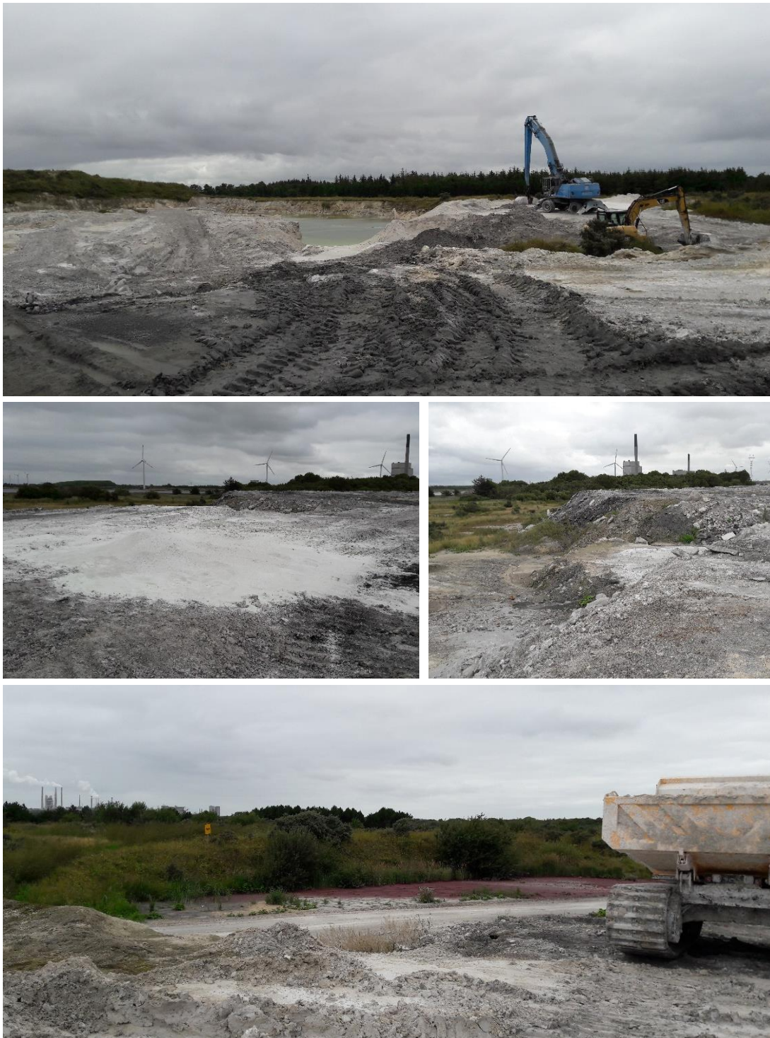
Figur 3. Øverst: Toppen af deponeringsanlægget Støvsøen set mod øst. Midterst tv: Hvid cement i område for råmel og uforbrændte klinker. Midterst th: kant af deponi mod nordvest. Nederst: Spor efter slam (rødfarvning) ved køreområde.
