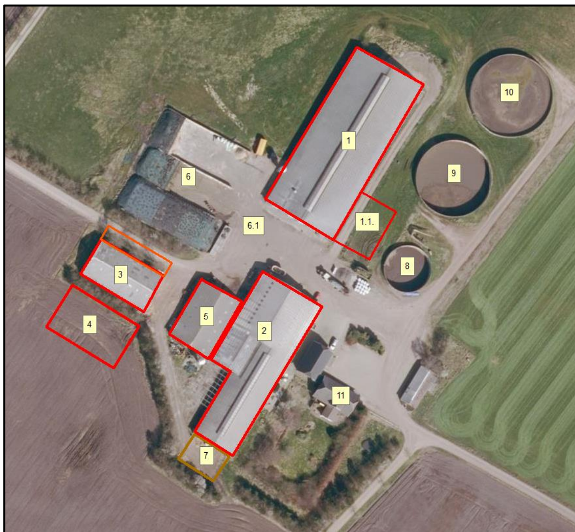
Figur 4. Oversigt over husdyrbrugets bygninger.
