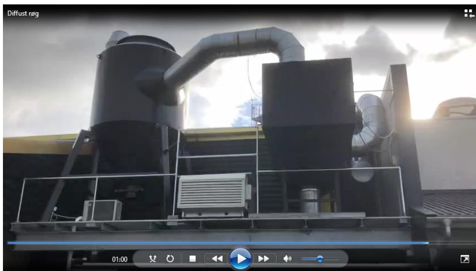
Billede fra video. Blæser, filter og afkastet (anes bag ved filteret)
