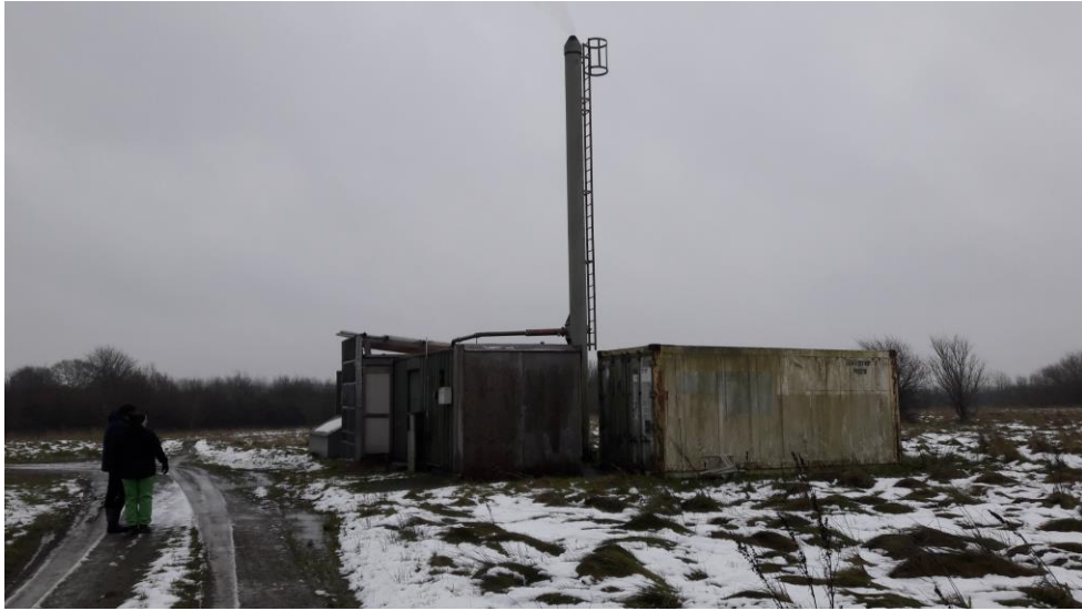
Figur 4. Gasmotorhus hvor deponigas afbrændes underproduktion af el til offentligt el-net.
