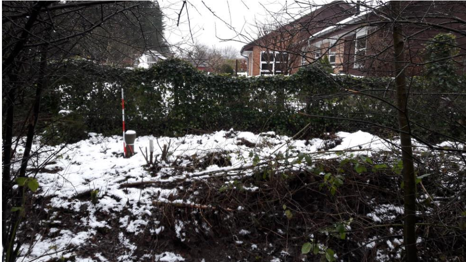
Figur 7. Gasmoniteringsboring i deponiets nordøstlige hjørne nær beboelsen Dybdalvej 4b.
