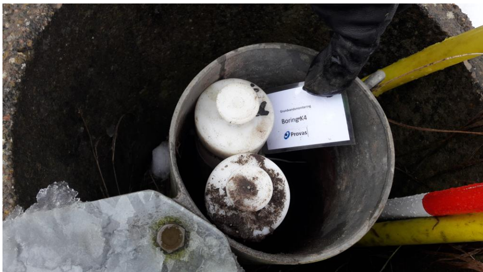
Figur 11. Brønd K4 opstrøms boring med 2 filterrør
