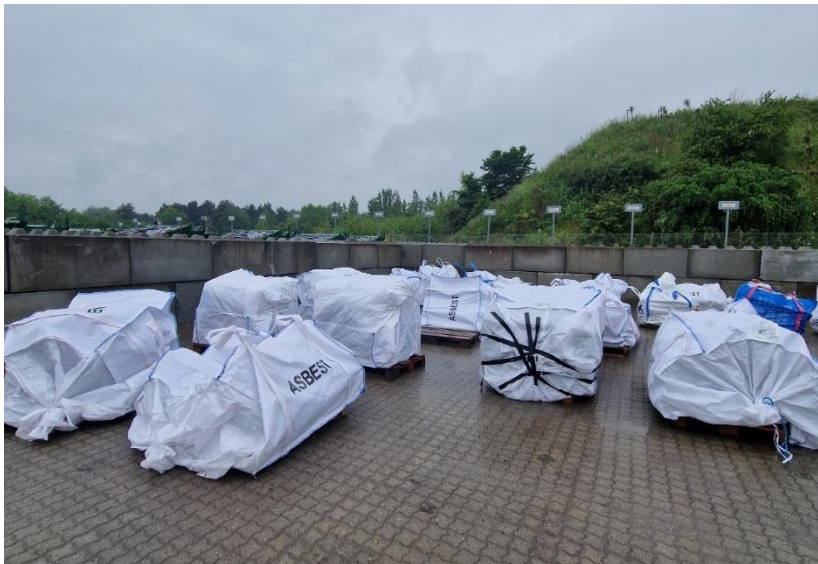
Foto 1: Modtageplads for asbestholdigt affald
